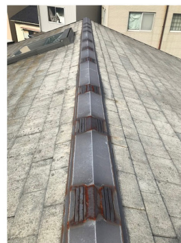
施工前 (コロニアル屋根)
